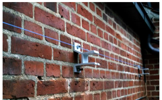
Brug snor mellem de yderste beslag for at flugte midterbeslag
